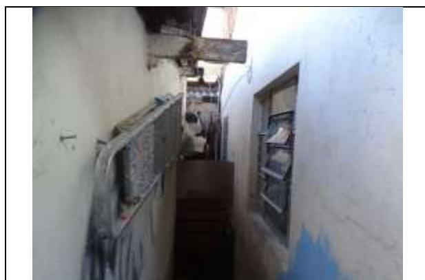
Foto 12 - Vista de corredor entre a Casa 01 e a Casa 02.
