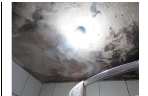
Foto 7 - Vista do banheiro da Casa 01.
