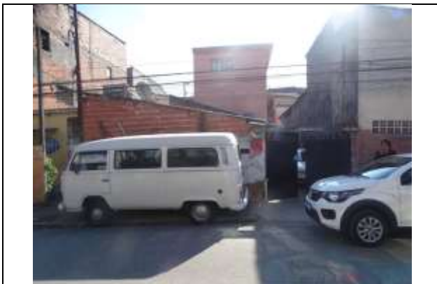
Foto 1 - Vista frontal do imóvel objeto.
