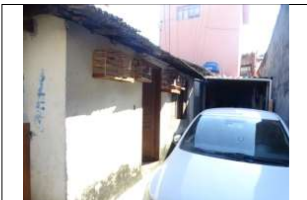
Foto 3 - Vista da fachada da Casa 01.
