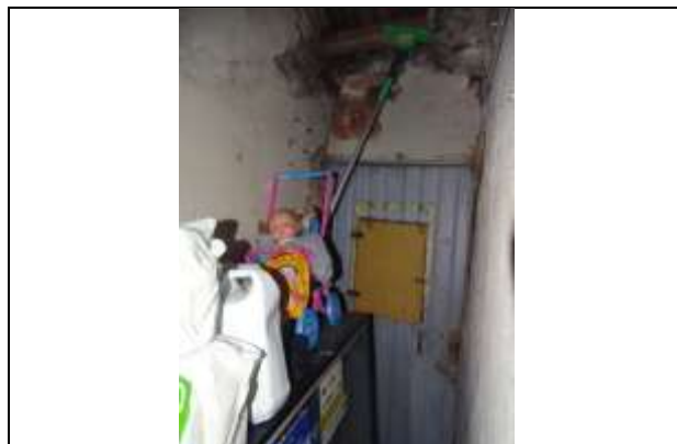
Foto 22 - Vista de corredor da Casa 02.
