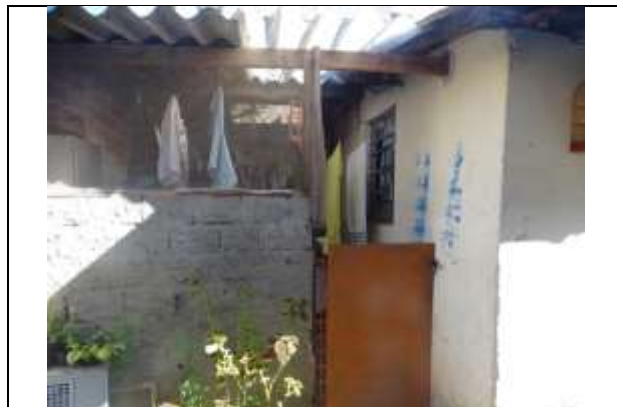
Foto 2 - Vista da fachada da Casa 01.
