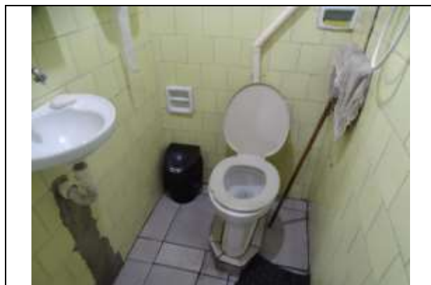
Foto 20 - Vista do banheiro da Casa 02.
