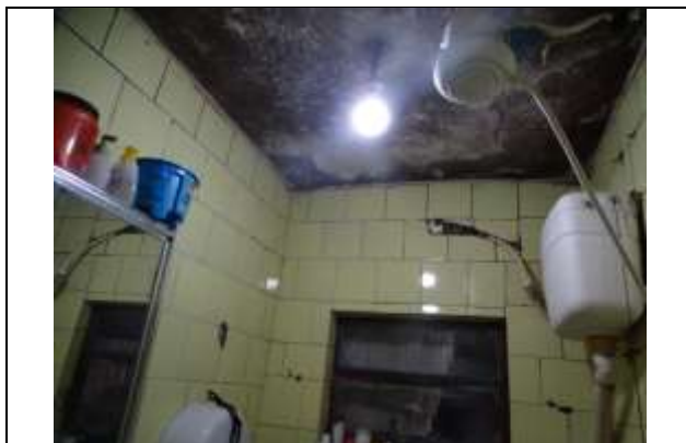
Foto 21 - Vista do banheiro da Casa 02.
